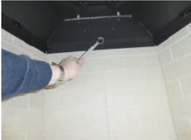
1. Halter für Innenauskleidung mit Maulschlüssel SW 19 lösen (3x M12 x 20)...
