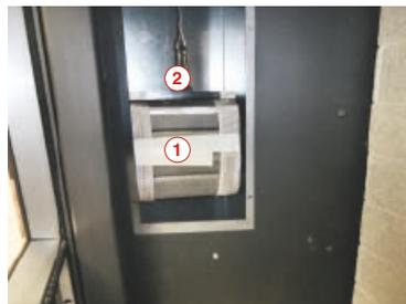
5. Die beiden oberen Ausgleichsgewichte (links u. rechts) anheben und über seitliche Nut aus der Halterung ziehen.
