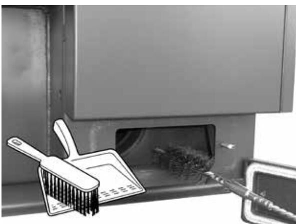
Muster – die Reinigung des Rauchkanals – unterer Deckel
