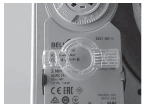
Abb. 4.26 Kupplung entriegelt
