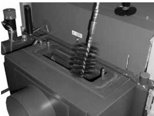
Vorführung der Reinigung des Rauchkanals mit Drahtbürste.
